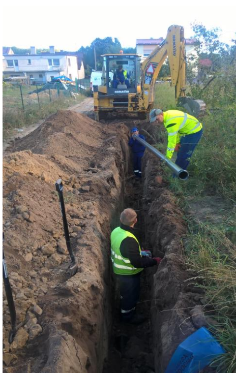
Prace budowlane na ul. Bocznej we Włoszakowicach.
