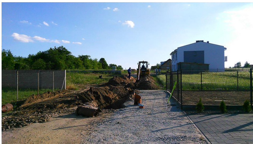
Prace budowlane na ul. Dziedzica we Włoszakowicach
