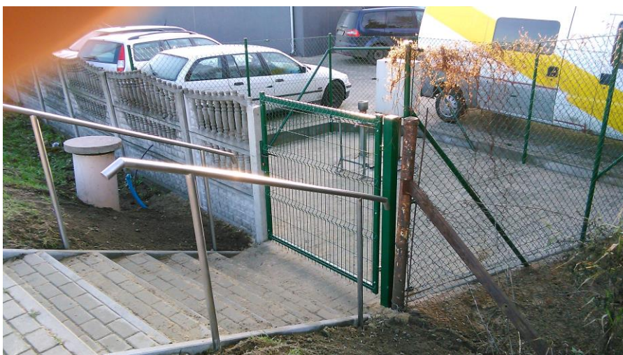
Remont pompowni P15
