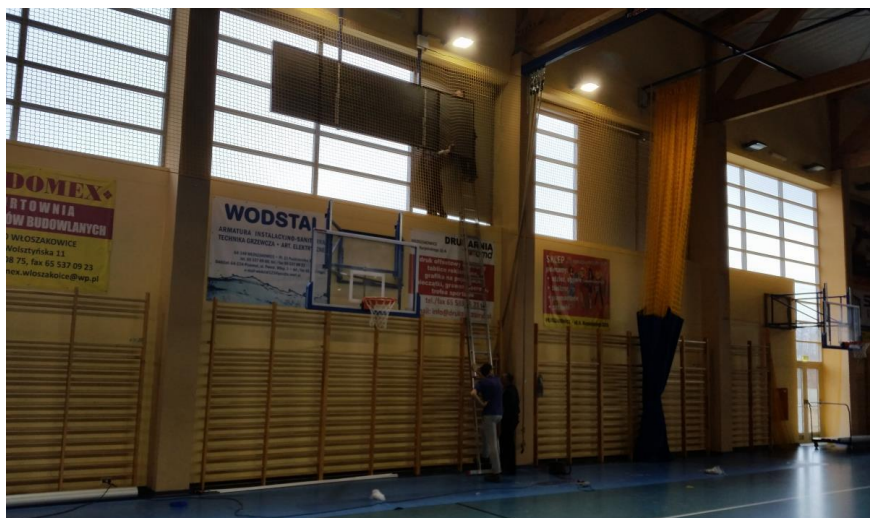
Montaż nowej rolety
