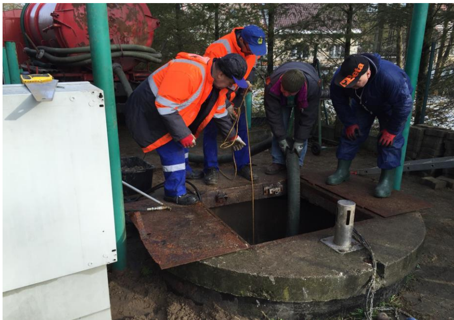
Remont pompowni ścieków
