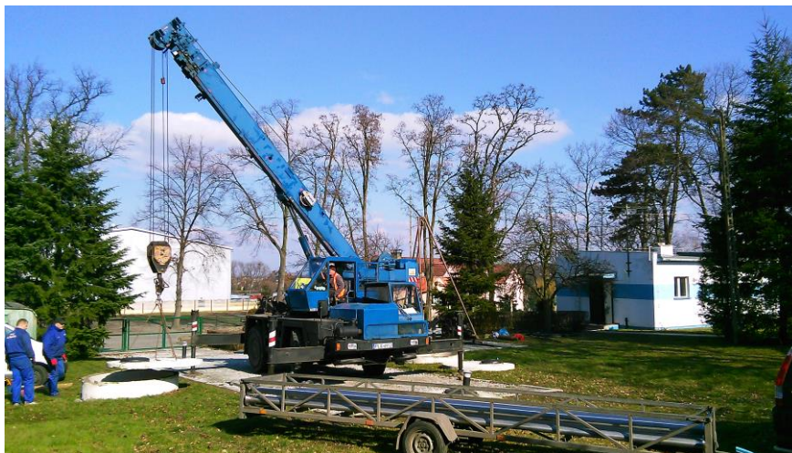
Prace przy remoncie studni głębinowych
