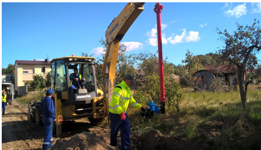
Prace budowlane na ul. M. Górnego w Krzycku Wielkim
