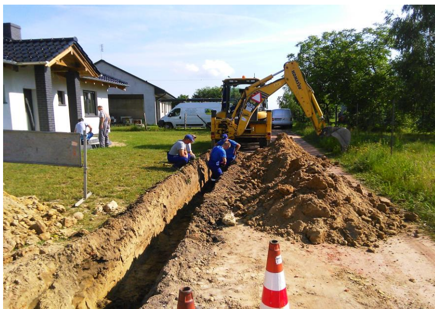
Prace budowlane przy budowie sieci na ul. Leśnej w Krzycku Wielkim
