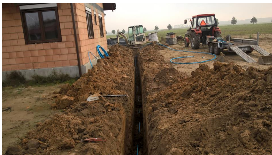
Budowa przyłącza wodociągowego
