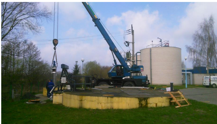
Montaż sita pionowego
