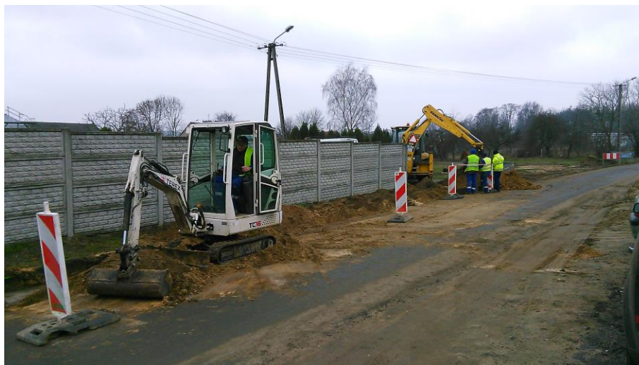
Prace budowlane na ul. Słonecznej w Grotnikach
