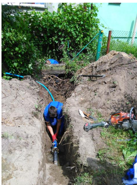
Wymiana przyłącza wodociągowego
