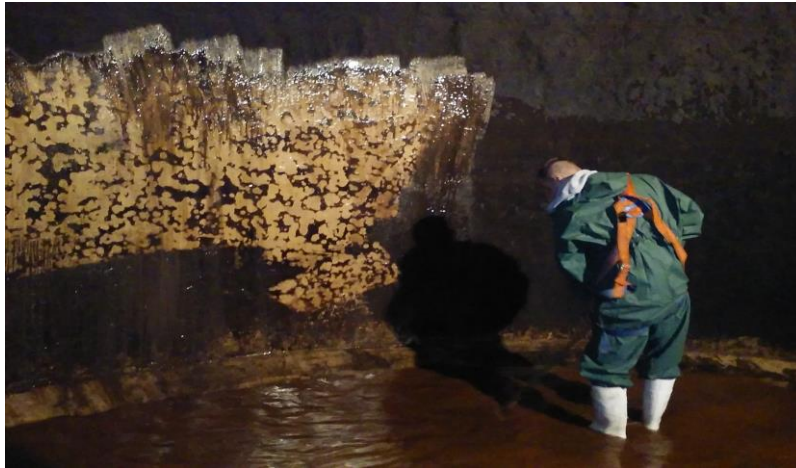
Czyszczenie zbiornika retencyjnego
